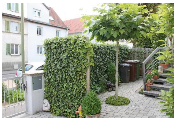
Slika 5. Primjer izvedenih „zelenih“ zidova za zaštitu od buke
