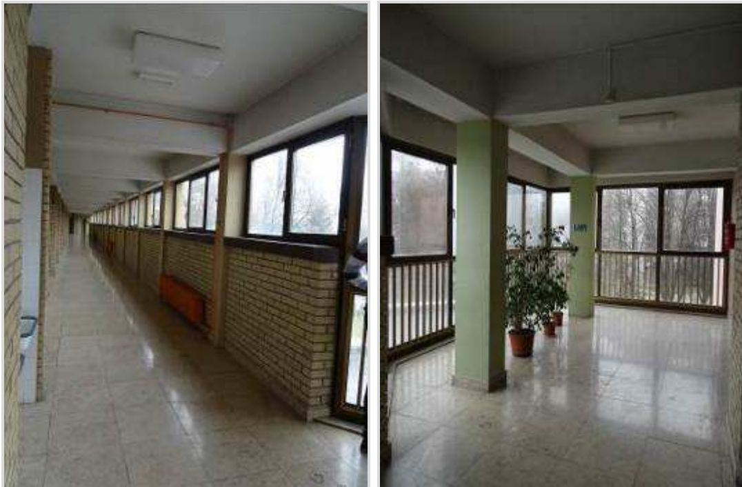
Slika 21: Bravarija od aluminijskih profila, krilo na krilo
