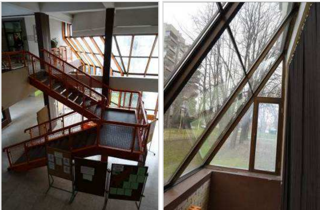
Slika 22: Stijene pod kutem u odnosu na pročelja
