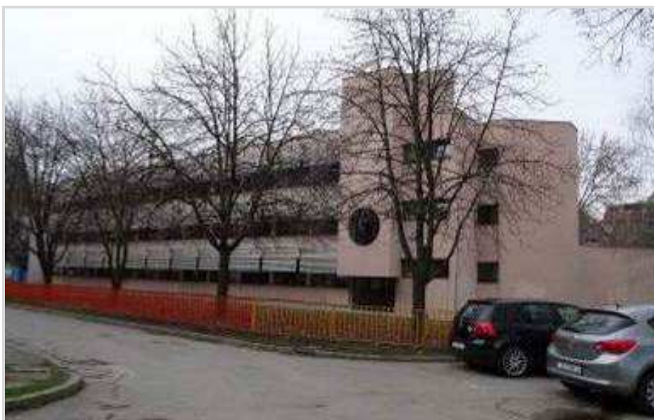
Slika 11: OŠ "Mladost" jugoistočno pročelje dilatacije IV
