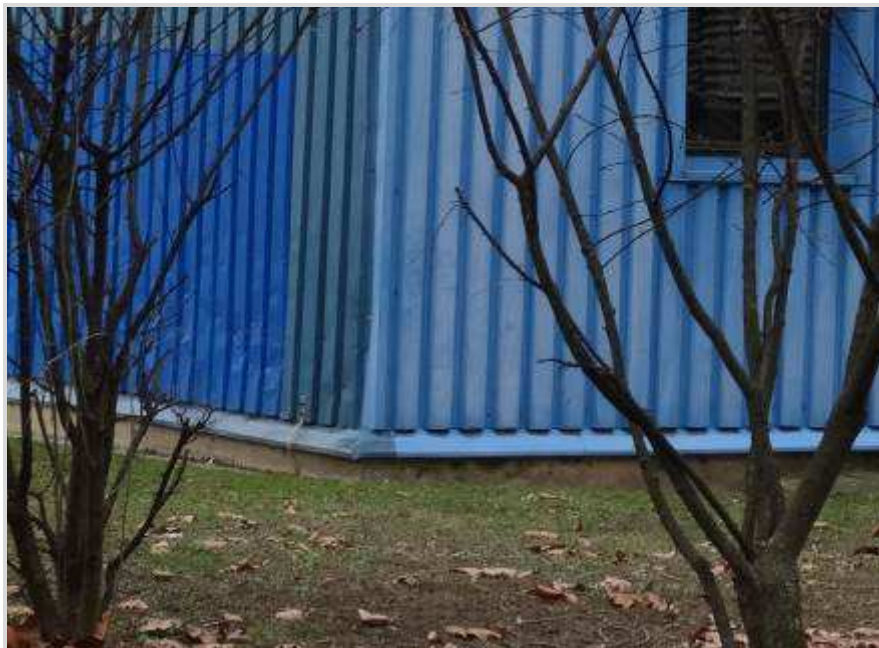
Slika 26: Nadtemeljni zidovi nastavno sportske dvorane
