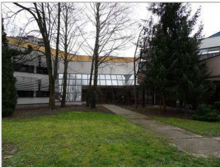
Slika 15: OŠ "Mladost" sjeverno pročelje dilatacije III (hol)
