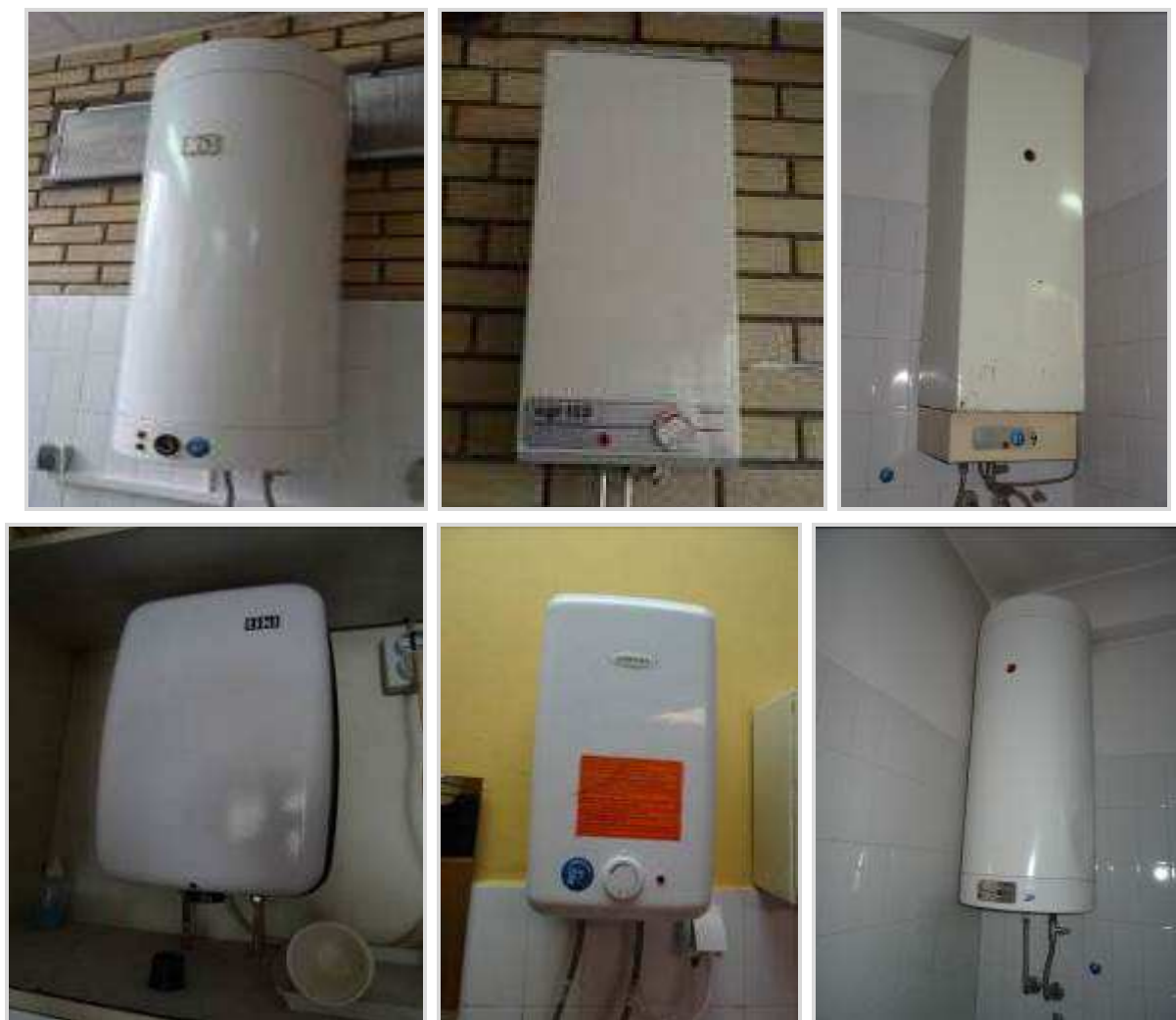
Slika 47: Električne grijalice vode
