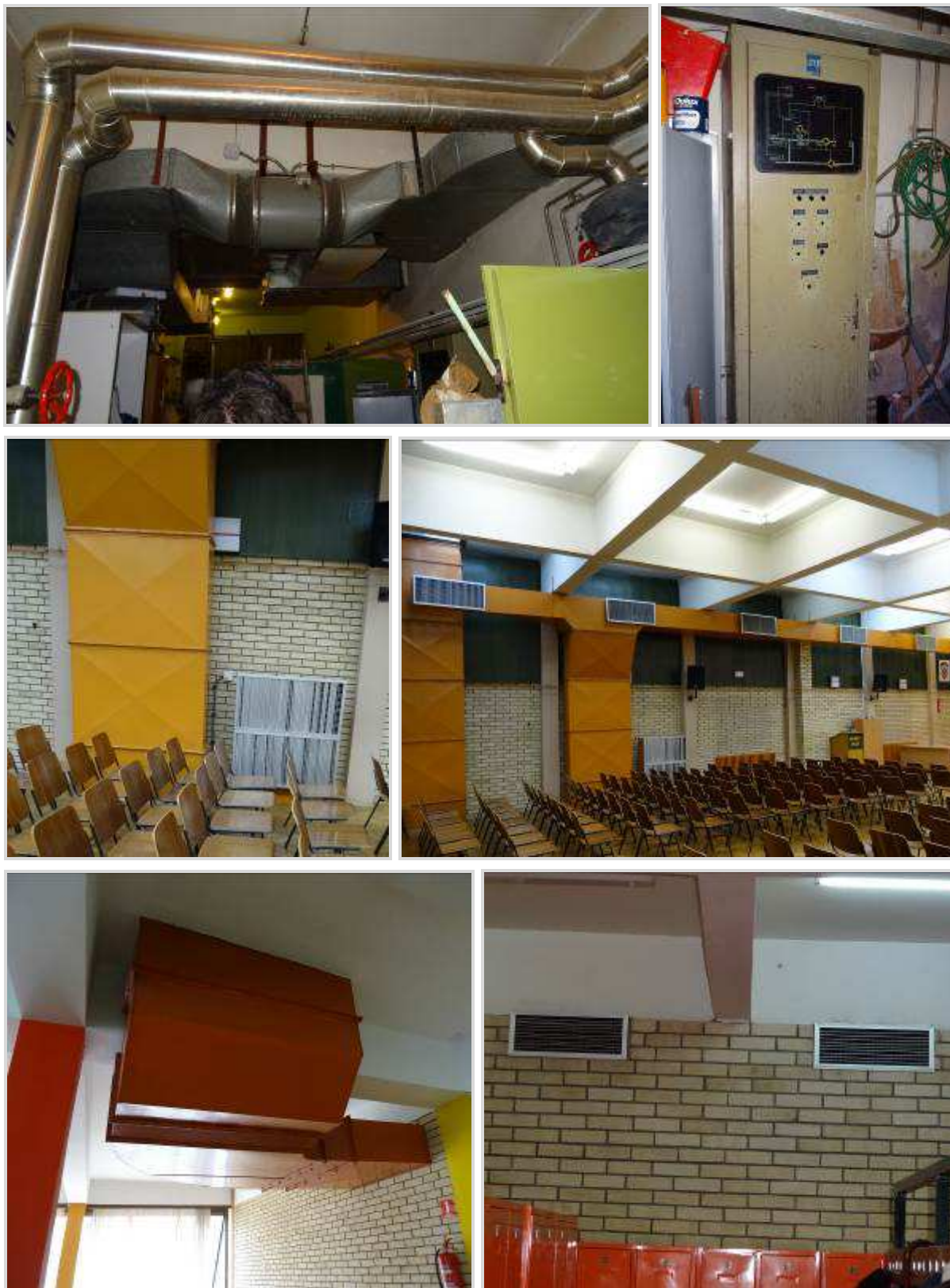
Slika 44: Dijelovi prozračivanja dvorane za priredbe i garderoba (nije u radu)
