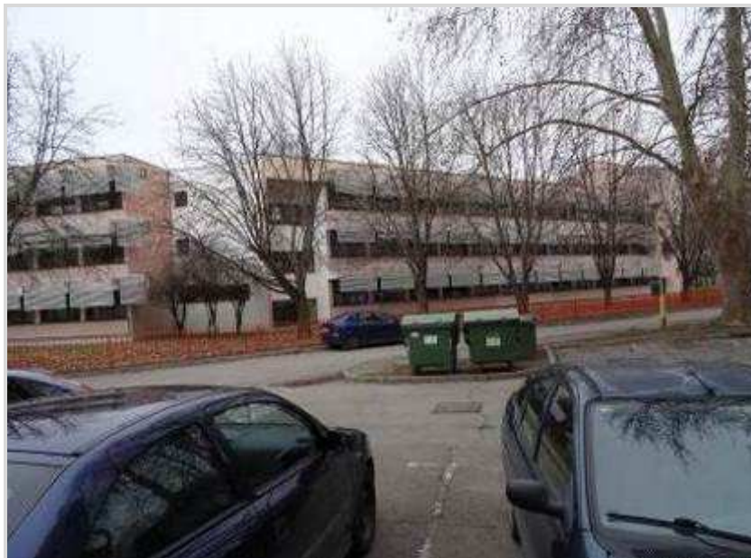
Slika 24: Zaštita od sunčevog zračenja sa vanjske strane (brisače)
