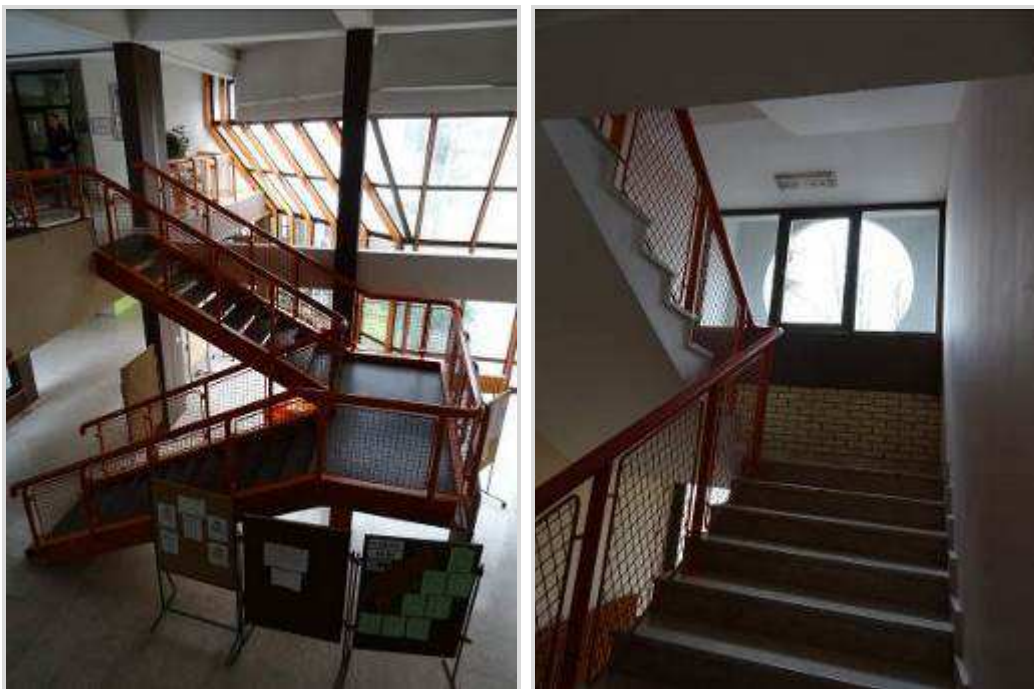
Slika 25: Dvokraka stubišta kroz građevinu
