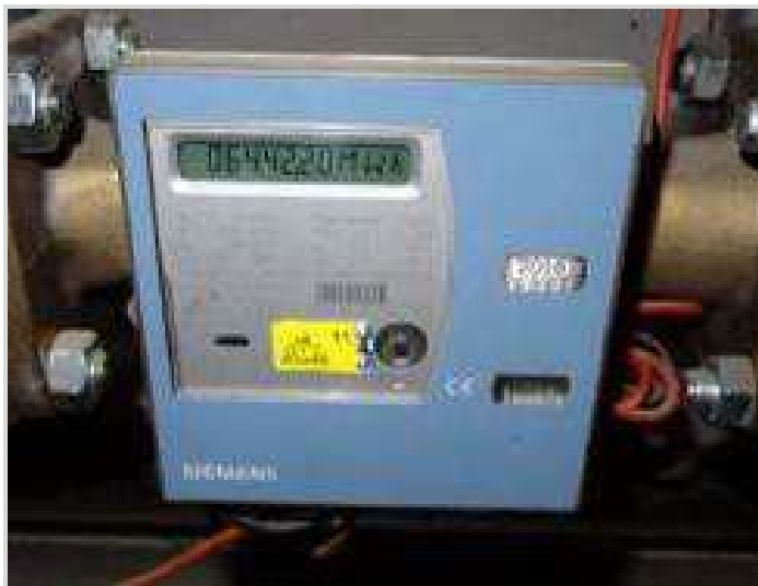
Slika 41: Programski uređaj, kalorimetar i termoelektrični prolazni ventil
