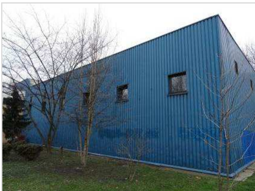
Slika 27: Limena obloga vanjski zidovi nastavno sportske dvorane
