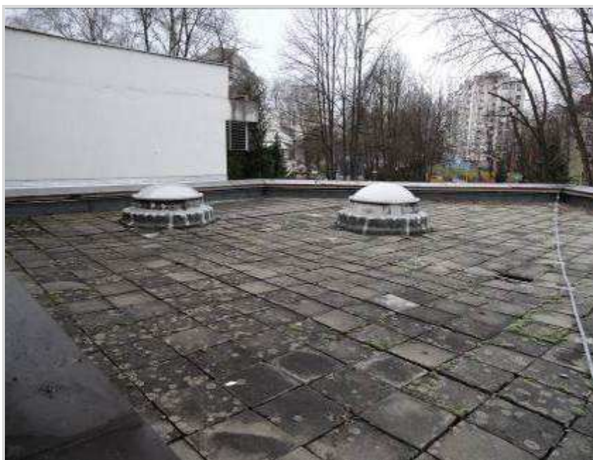
Slika 20: Hidroizolacija ravnog krova
