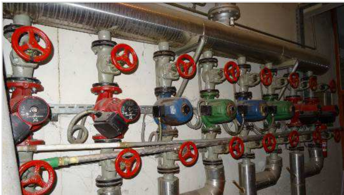
Slika 39: Električne crpke u sustavu centralnog grijanja
