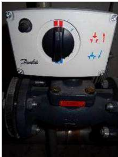
Slika 40: Programski uređaj, kalorimetar i termoelektrični prolazni ventil
