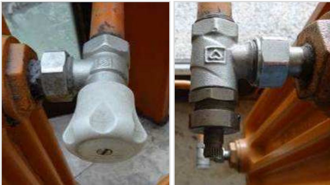
Slika 38: Obični ventili na radijatorima
