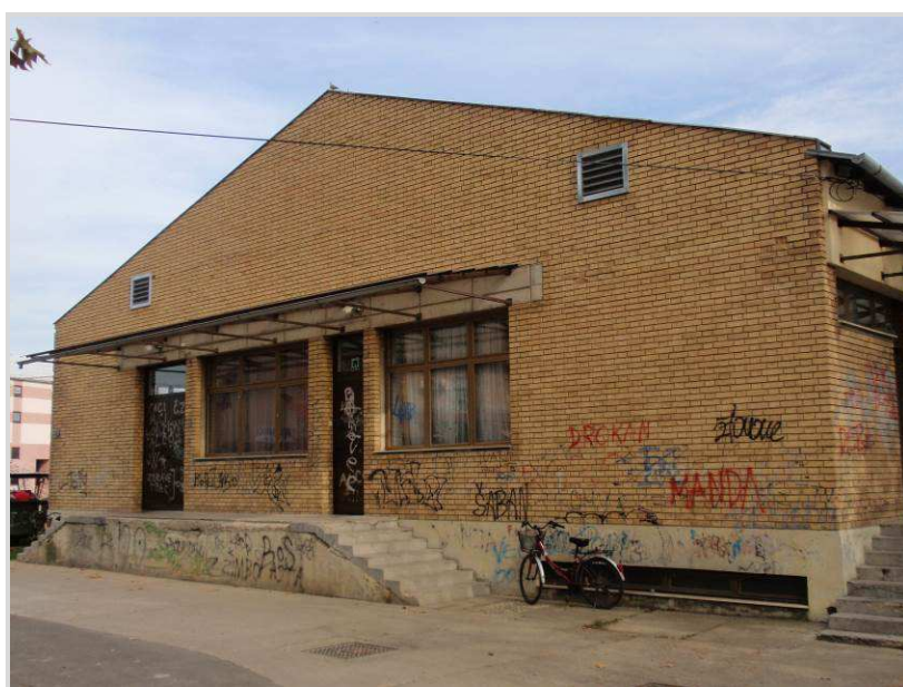
Slika 3: Centralna kuhinja, pogled sa zapada
