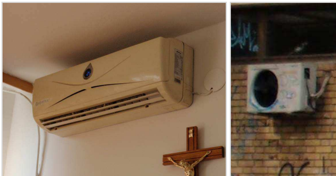
Slika 18: Unutrašnja i vanjska jedinica rashladnog split uređaja
