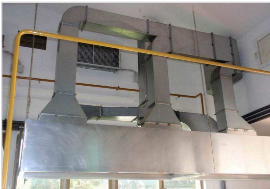
Slika 20: Jednostruke kuhinjske nape sa prozračivanjem kroz fasadu
