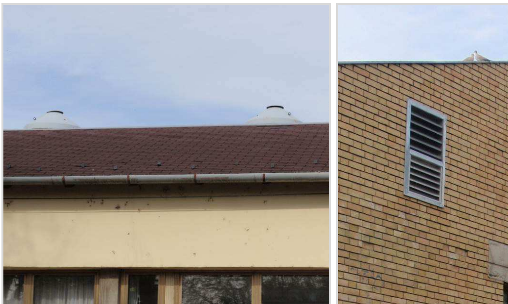
Slika 21: Krovni i zidni otvori za prozračivanje kuhinjskih napa
