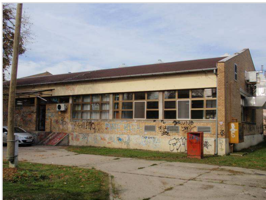
Slika 6: Centralna kuhinja, južna strana zgrade
