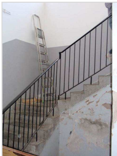
Slika 8: Centralna kuhinja, podrumsko stubište
