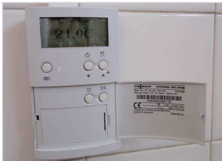
Slika 16: Upravljačka naprava plinskog bojlera
