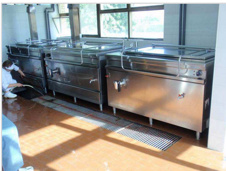
Slika 10: Centralna kuhinja, pod sa slivnikom
