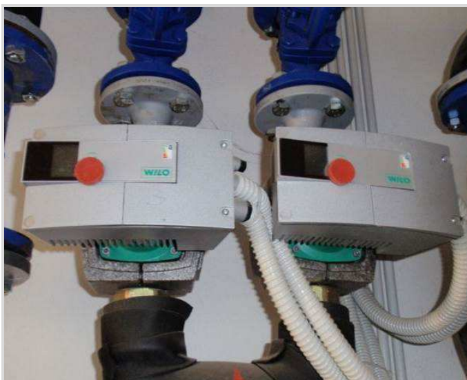
Slika 26: Crpke u sustavu grijanja
