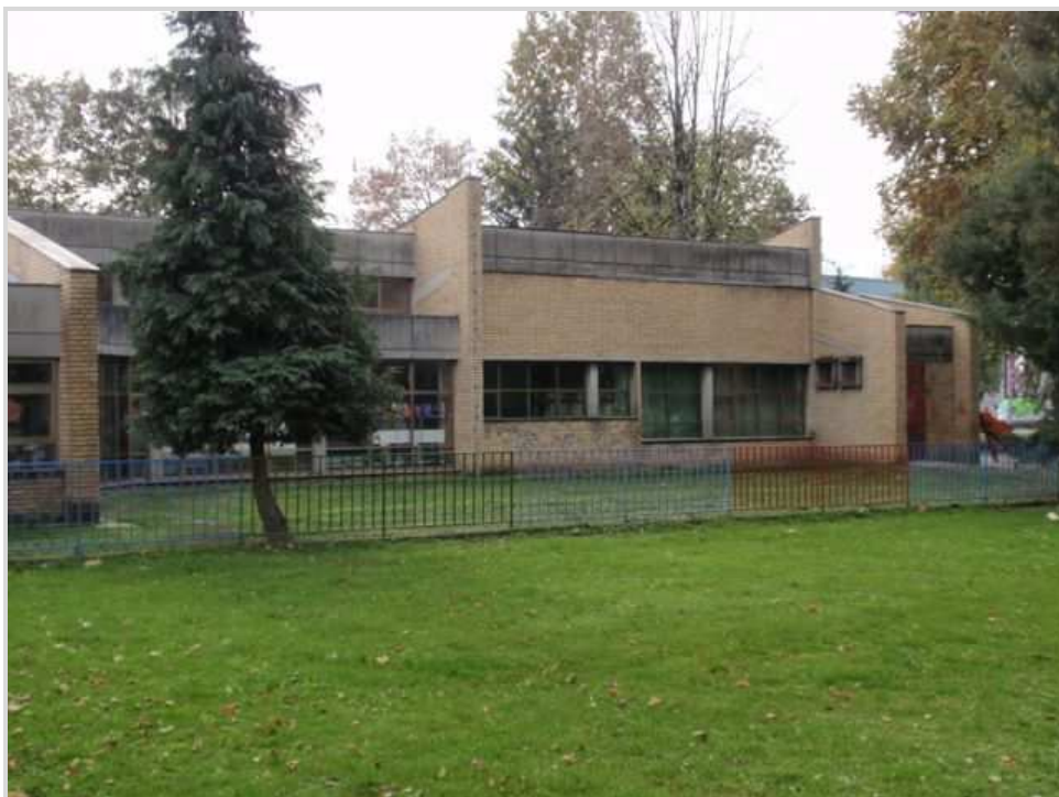
Slika 6: DV "Pčelica", pogled na sjeverni trakt sa sjevera
