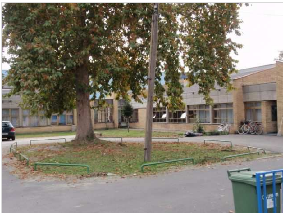
Slika 12: DV "Pčelica", pogled sa sjeveroistoka
