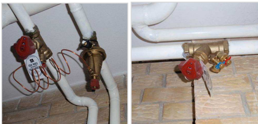
Slika 25: Automatski i ručni ravnotežni ventili
