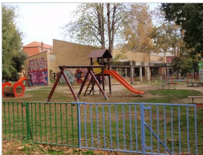
Slika 13: DV "Pčelica", pogled s jugozapada
