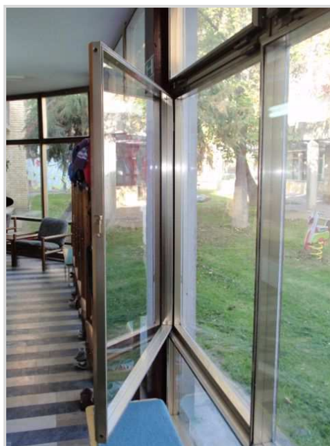
Slika 14: DV "Pčelica", aluminijska građevinska stolarija
