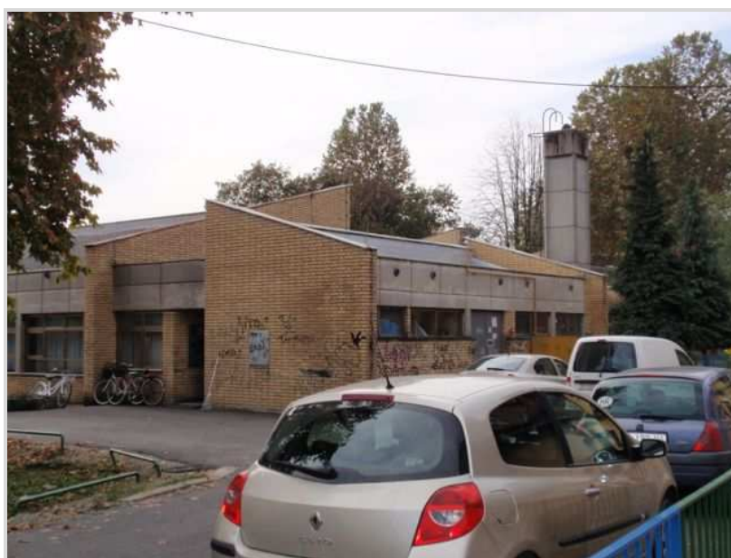
Slika 9: DV "Pčelica", pogled na kotlovnicu
