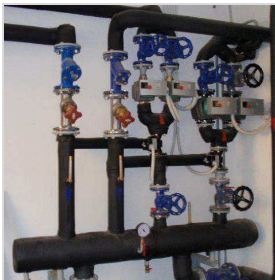
Slika 26: Crpke u sustavu grijanja
