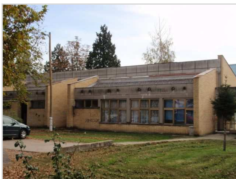
Slika 6: DJ "Tratinčica", pogled sa sjeveroistoka
