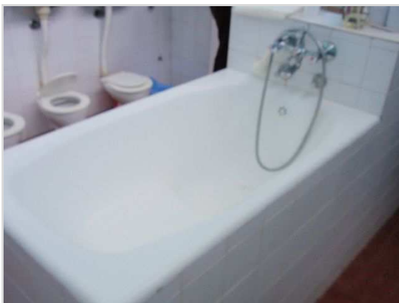
Slika 15: DJ "Tratinčica", sanitarni prostor
