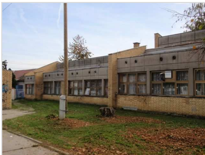
Slika 9: DJ "Tratinčica", pogled sa sjeverozapada na servisni dio
