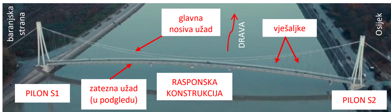
Slika 2. Pogled na desnu (uzvodnu) stranu mosta
