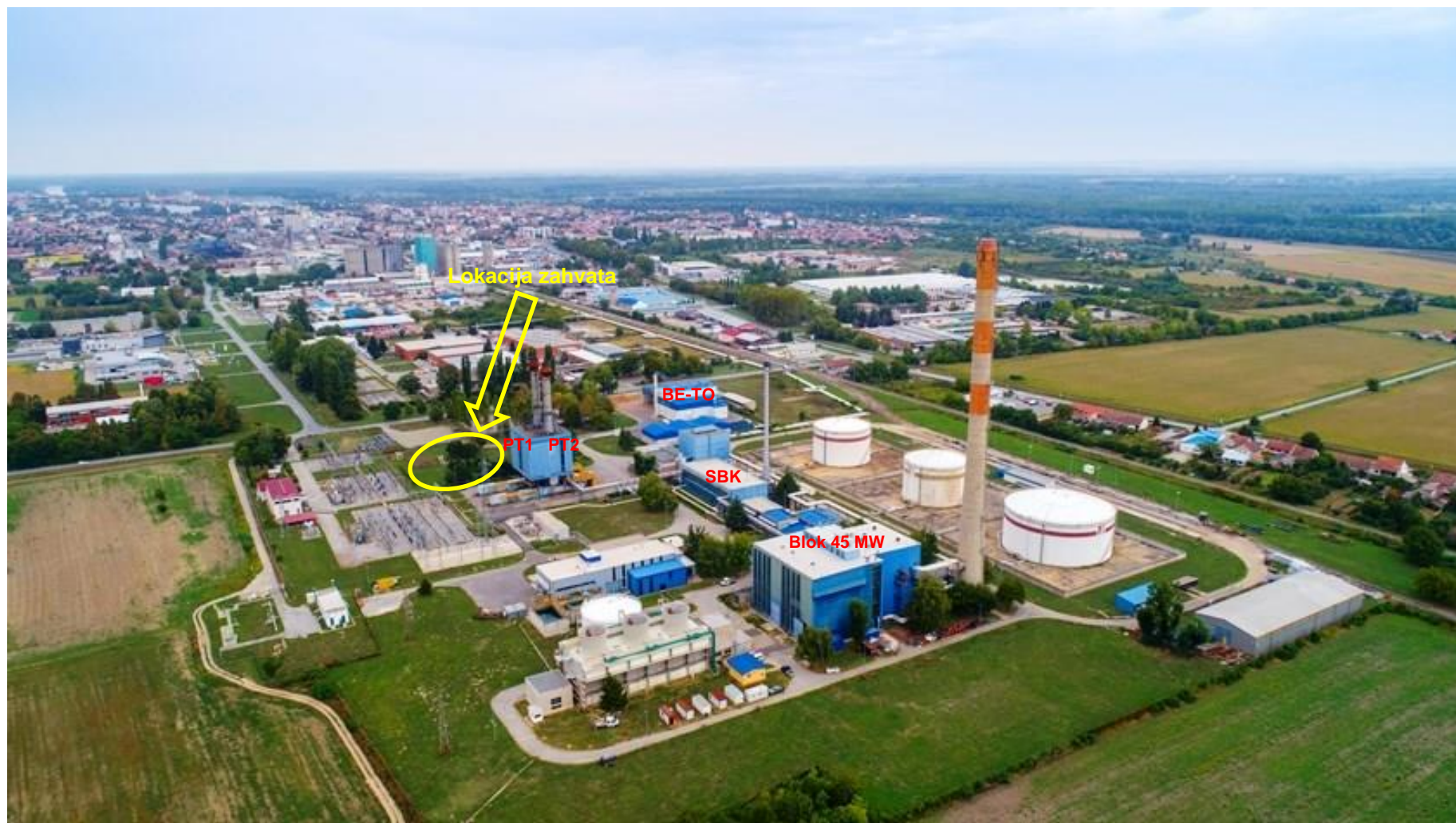
Sl. 1-4: Zračna snimka TE-TO Osijek, pogled na sjeverozapad (Izvor: HEP Proizvodnja d.o.o.)
