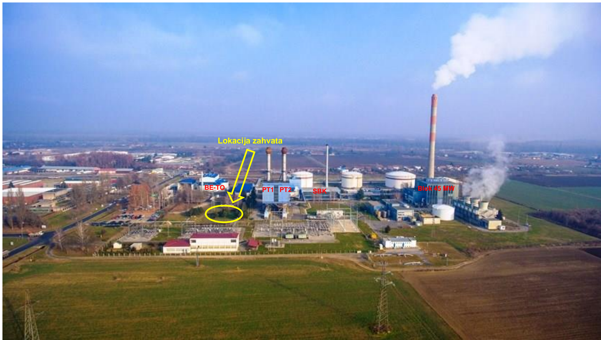
Sl. 1-3: Zračna snimka TE-TO Osijek, pogled na sjever (Izvor: HEP Proizvodnja d.o.o.)
