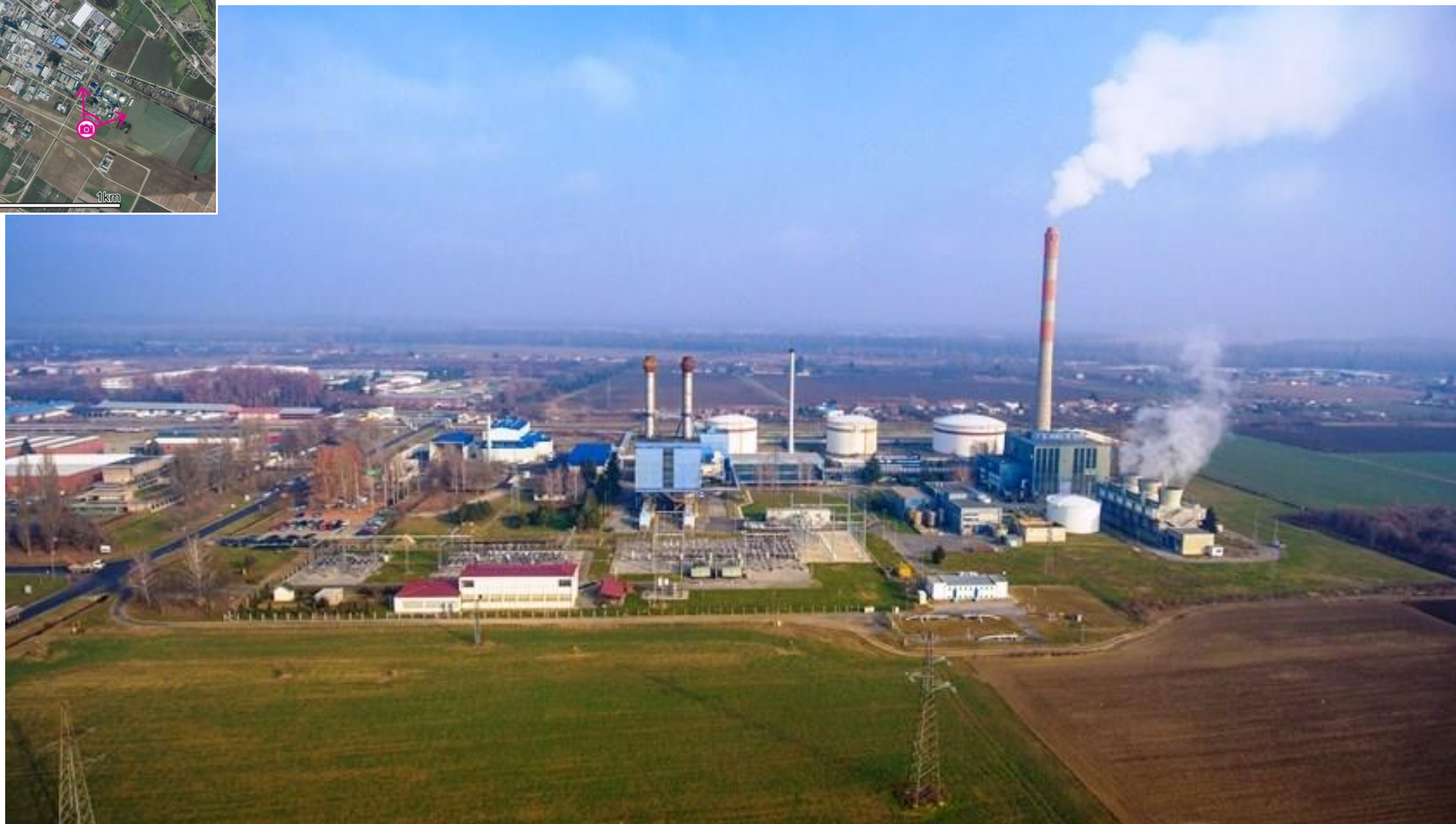
Sl. 3.11-5: Zračna snimka TE-TO Osijek, pogled na sjever (Izvor: HEP Proizvodnja d.o.o.)
