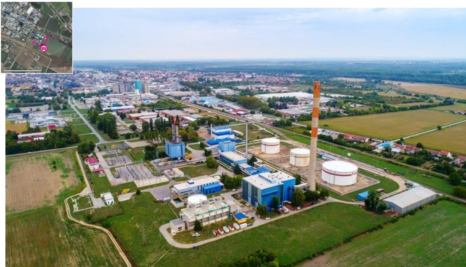
Sl. 3.11-6: Zračna snimka TE-TO Osijek, pogled na sjeverozapad (Izvor: HEP Proizvodnja d.o.o.)
