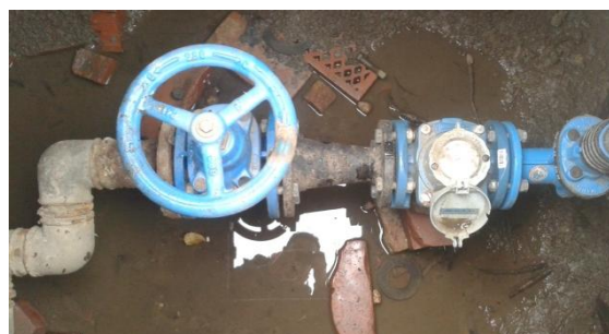
FOTOGRAFIJA 8: Primjer sanitarne opreme i vodomjera u zgradi
