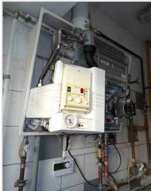
Slika 22: Plinski kotao u sustavu centralnog grijanja
