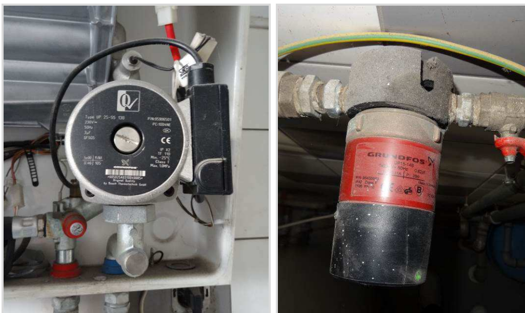
Slika 28: Cirkulacijske crpke u sustavu za pripremu PTV
