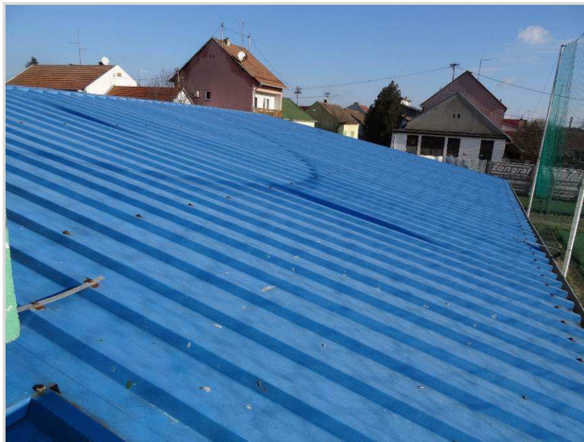
Slika 13: Zgrada SC "LIO" u Osijeku, profilirani lim kosog krova
