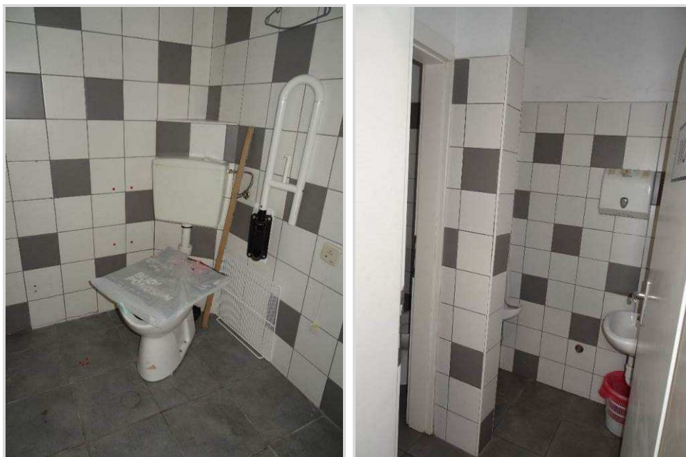
Slika 10: Obloga zidova keramičkim pločicama u sanitarnom čvoru
