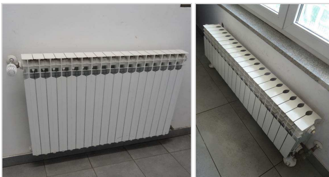
Slika 24: Aluminijska radijatori u sustavu centralnog grijanja
