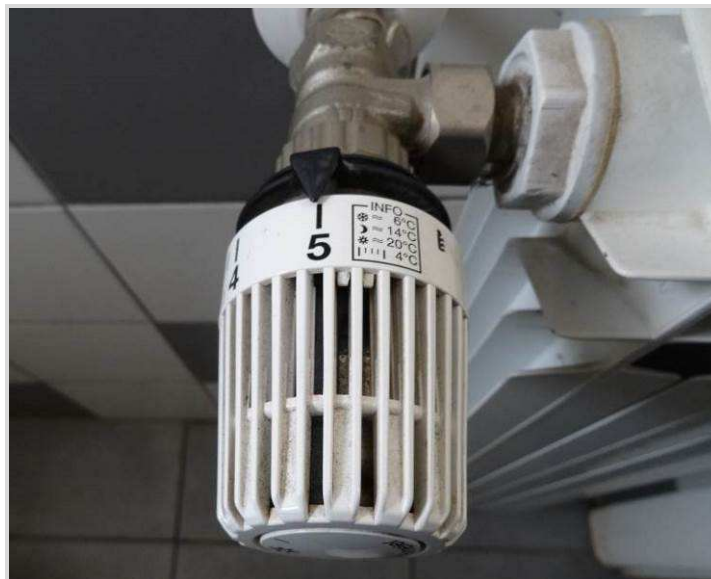
Slika 25: Termoregulacijski radijatorski ventil
