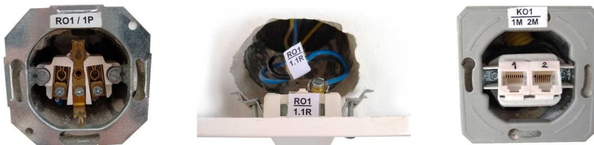
Slika 4.1-4 Označavanje priključnica jake, slabe struje i prekidača
