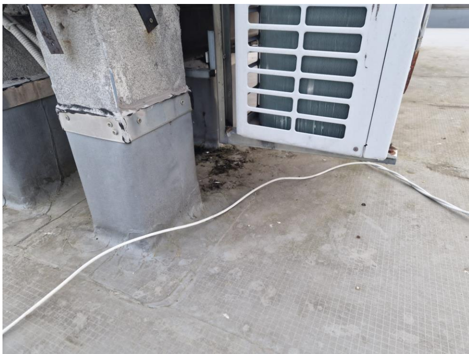
Slika 12. Vidljiva oštećenja na krovu
