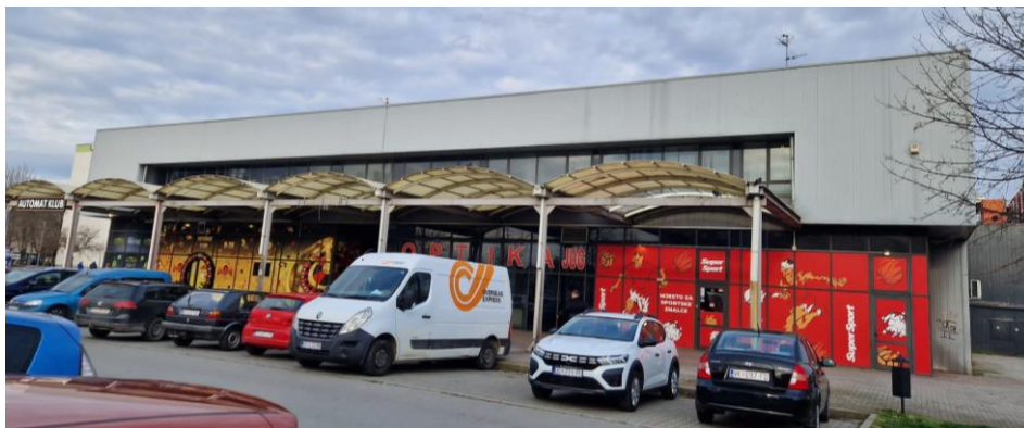
Slika 2. Predmetna zgrada trgovačkog centra, pogled na zapadno pročelje
