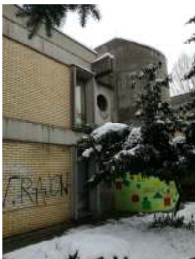
FOTOGRAFIJA 5: Zapadno pročelje
