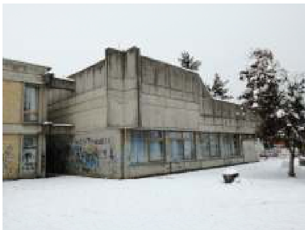
FOTOGRAFIJA 9: Istočno pročelje
