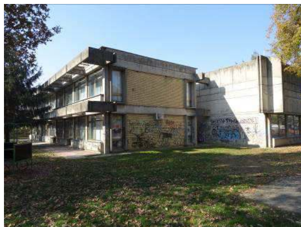
FOTOGRAFIJA 10: Istočno pročelje
