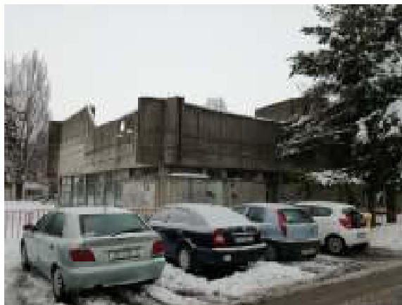
FOTOGRAFIJA 8: Sjeverno i istočno pročelje
