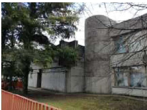
FOTOGRAFIJA 7: Sjeverno pročelje
