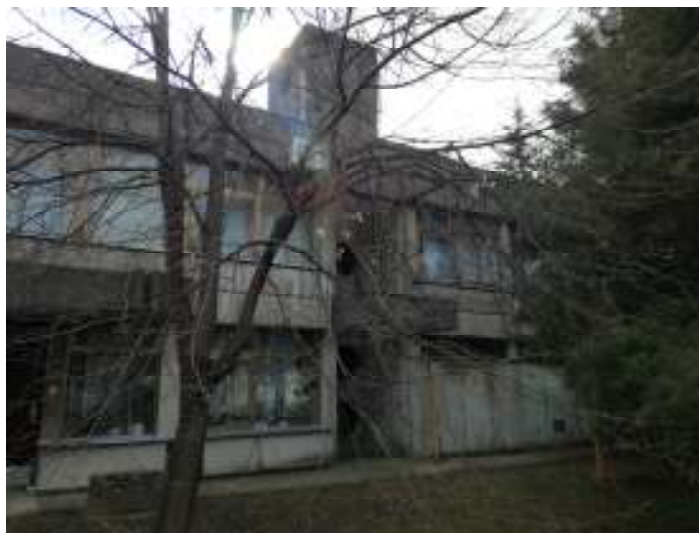
FOTOGRAFIJA 6: Sjeverno pročelje
