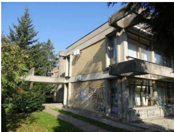
FOTOGRAFIJA 4: Zapadno pročelje
