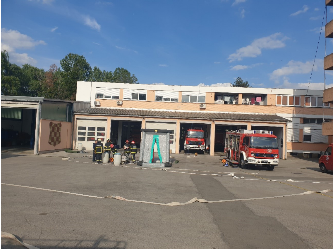
Postojeće stanje- krov-panel d=5cm- - zona 2
