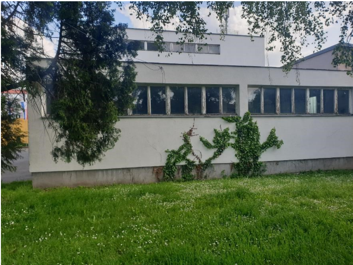
Postojeće stanje – dio sjevernog pročelja
