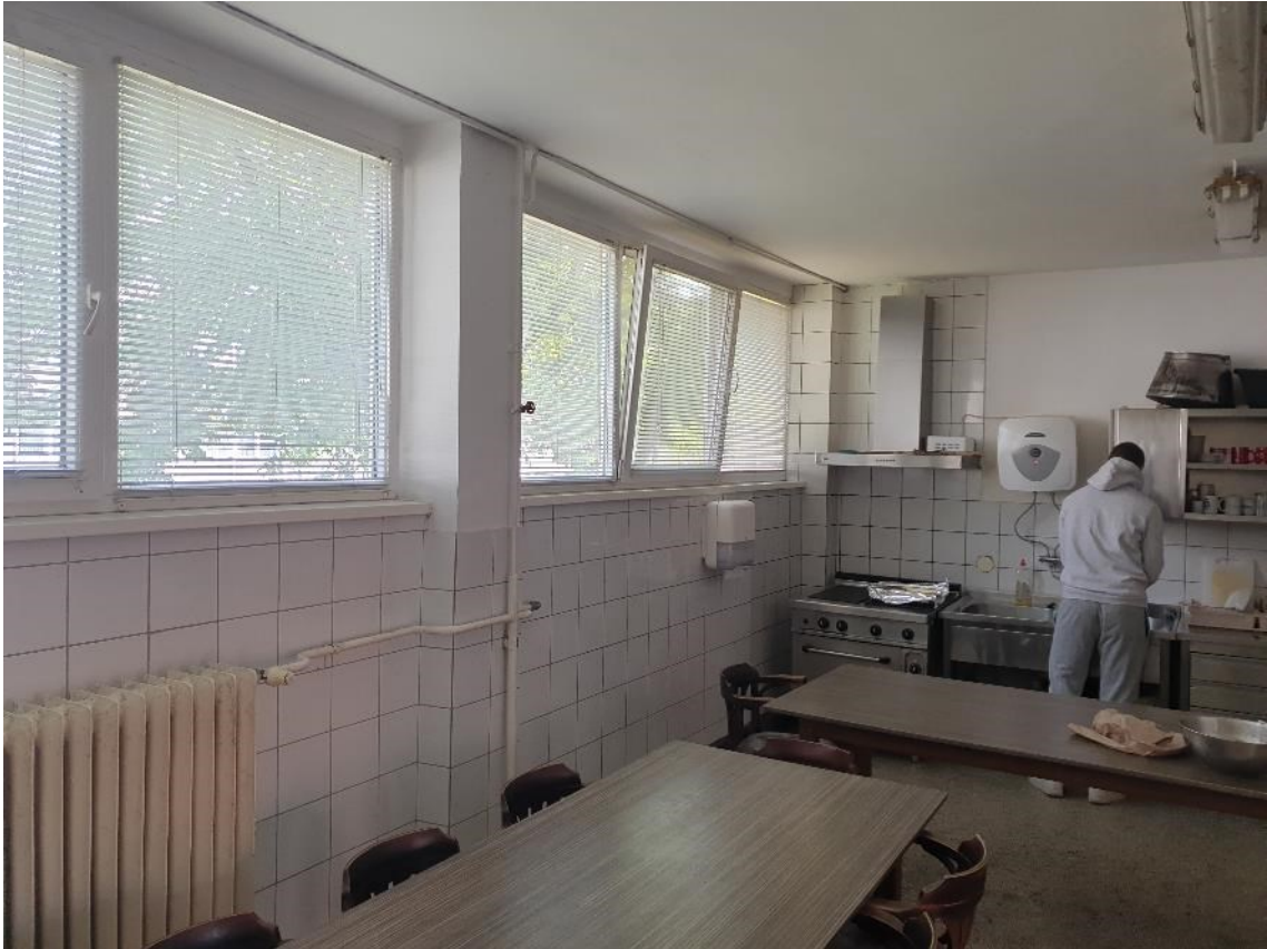
Postojeće stanje- PVC stolarija
