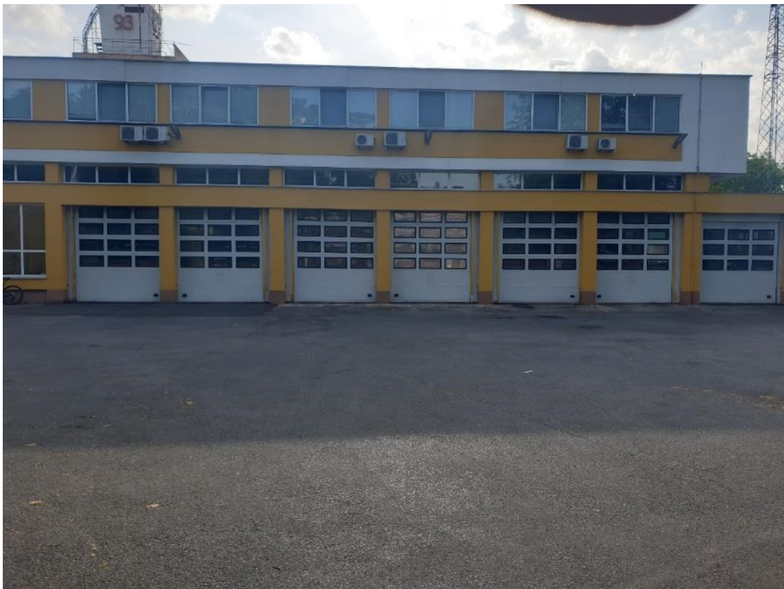
Postojeće stanje – dio istočnog pročelja
