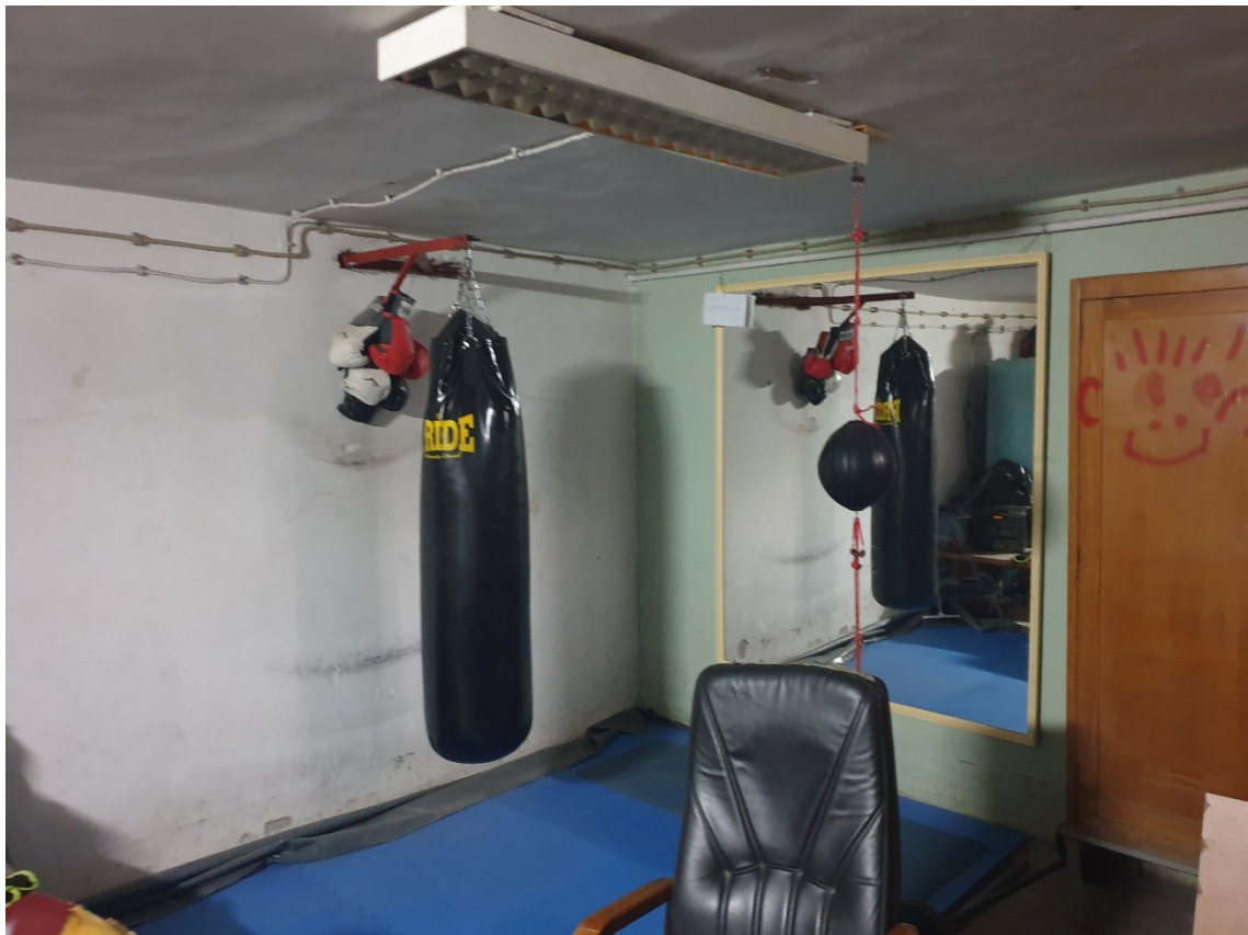
Postojeće stanje- strop podruma
