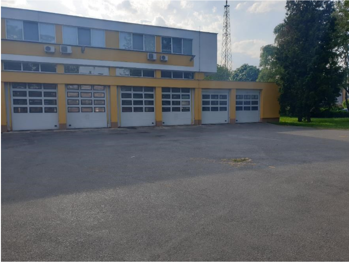
Postojeće stanje – dio istočnog pročelja
