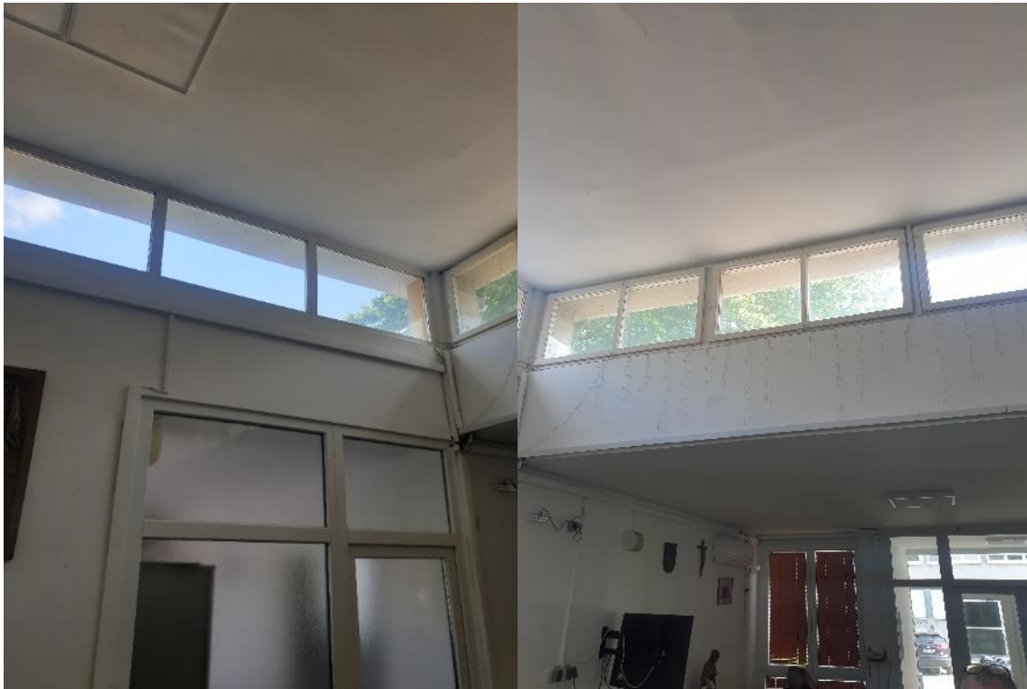
Vanjski prozori između etaža
