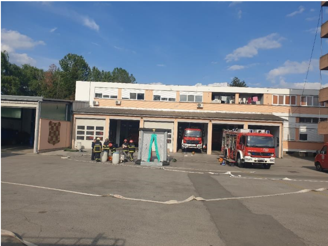
Postojeće stanje - zapadno pročelje
