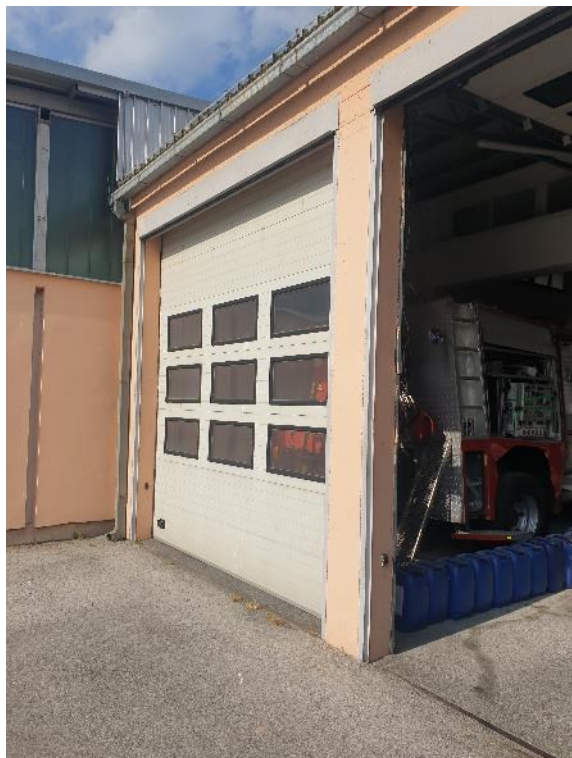
Postojeća garažna vrata- aluminijski panel
