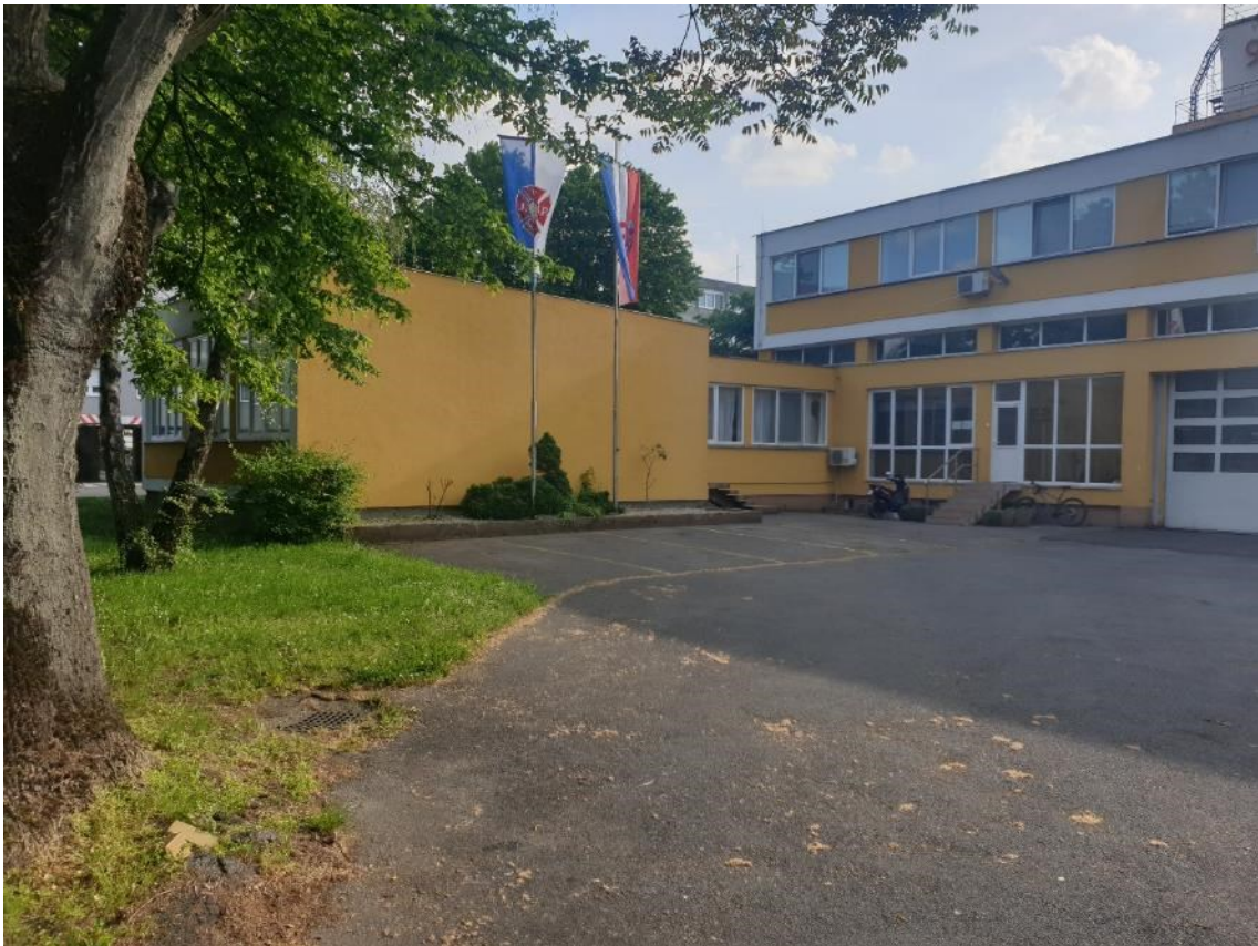
Postojeće stanje – dio sjevernog i istočnog pročelja
