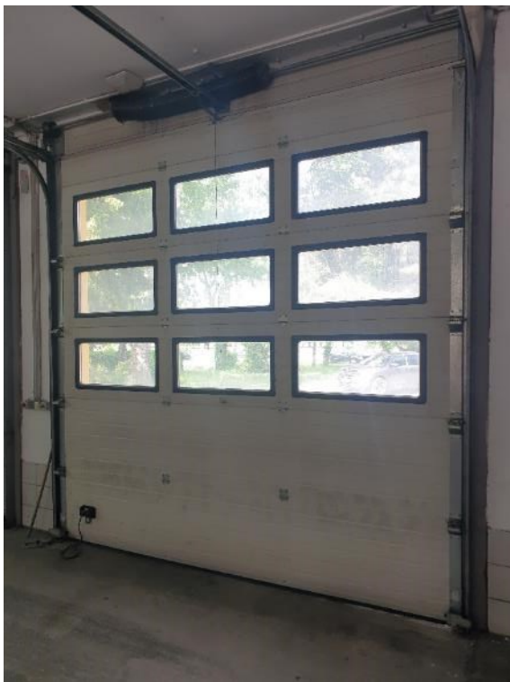
Postojeća garažna vrata- aluminijski panel
