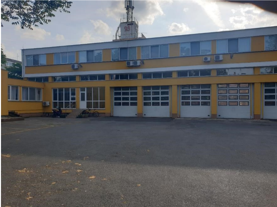
Postojeće stanje – dio istočnog pročelja
