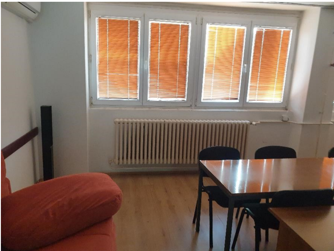
Postojeće stanje- PVC stolarija
