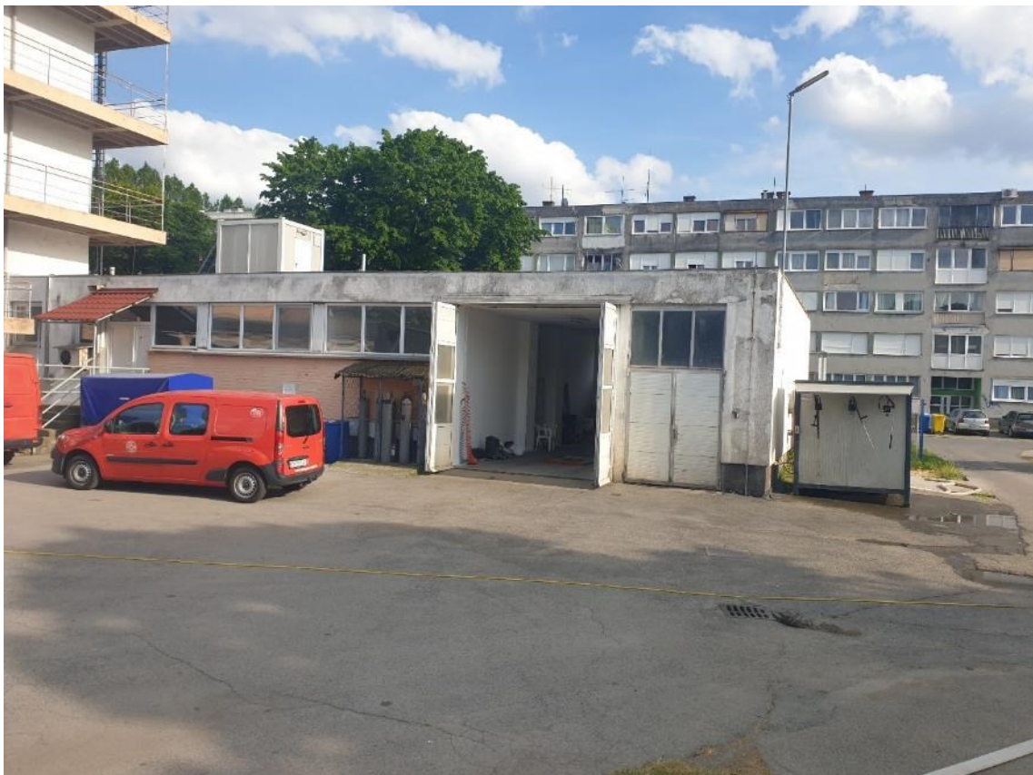
Postojeće stanje – dio sjevernog pročelja
