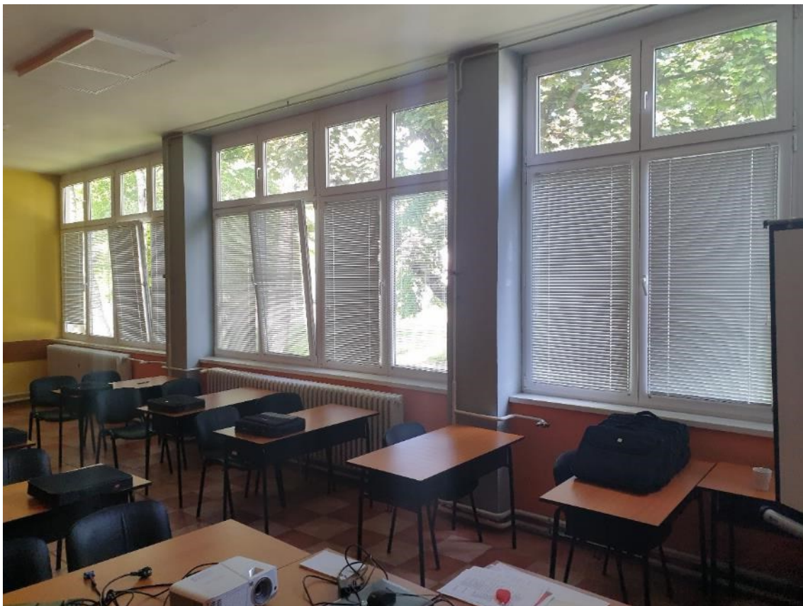
Postojeće stanje PVC stolarije
