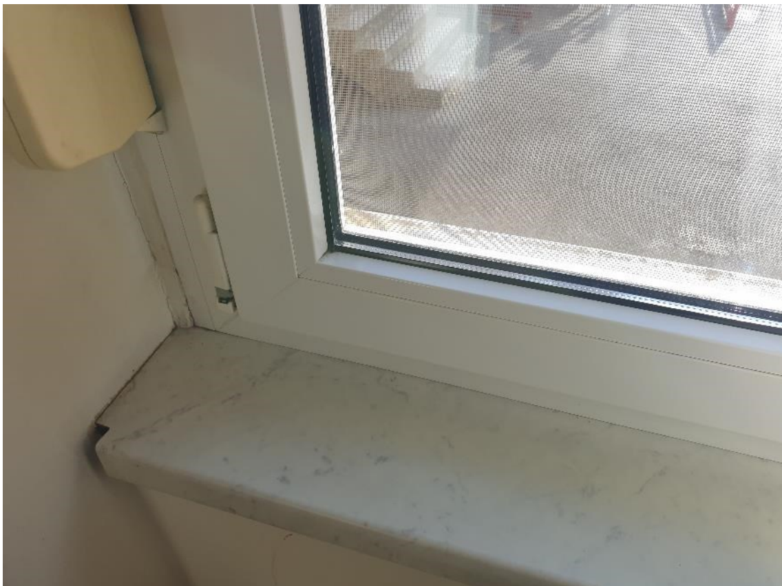
Postojeće stanje- PVC stolarija
