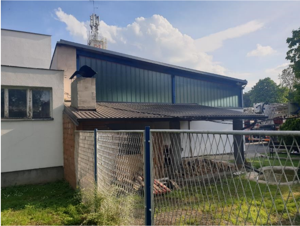
Postojeće stanje – dio sjevernog pročelja
