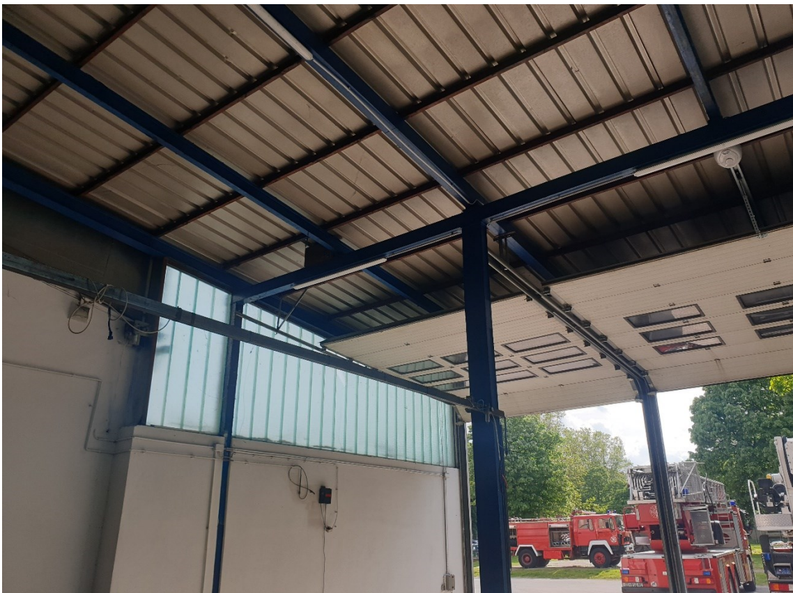
Postojeće stanje- limeni krov
