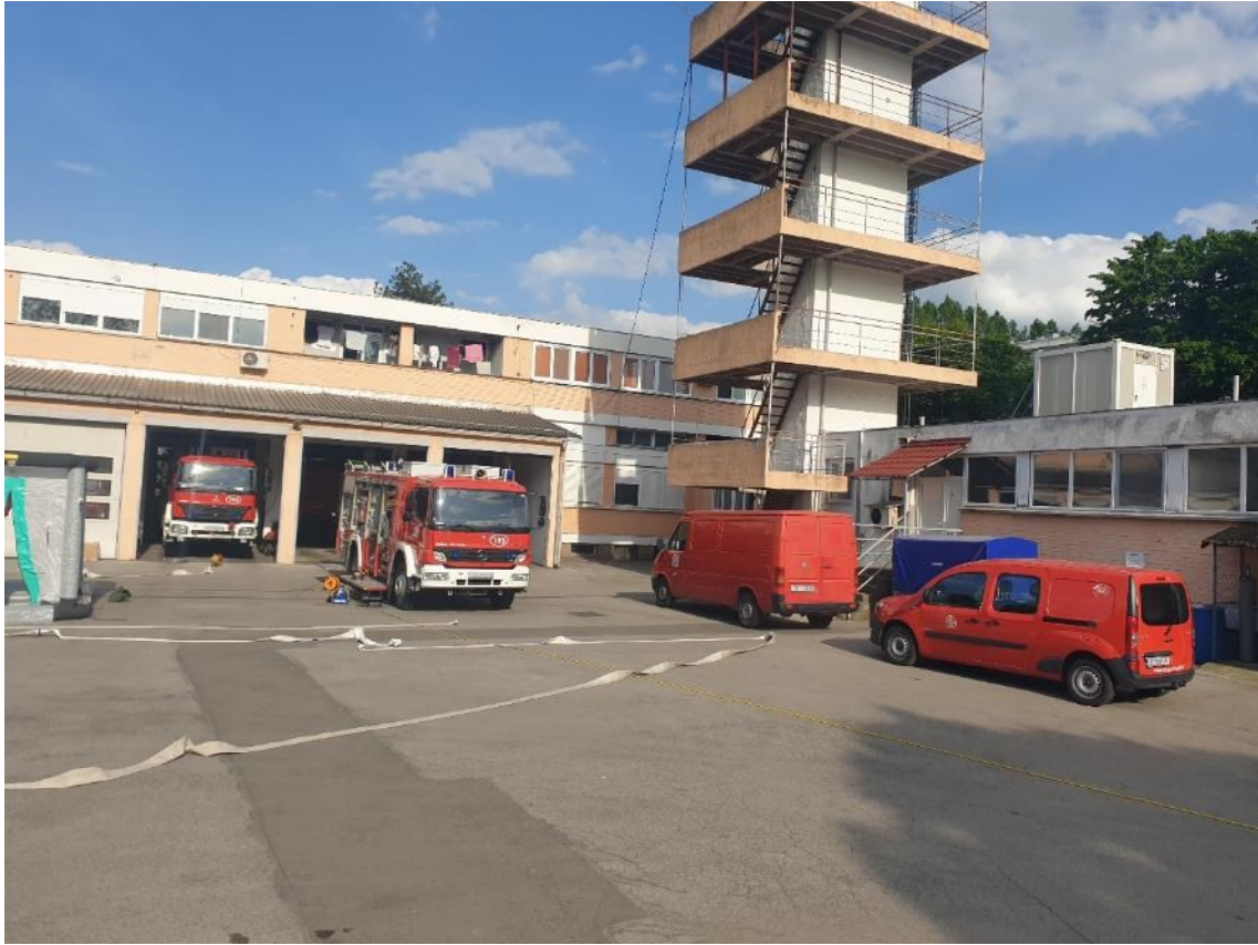
Postojeće stanje - zapadno pročelje
