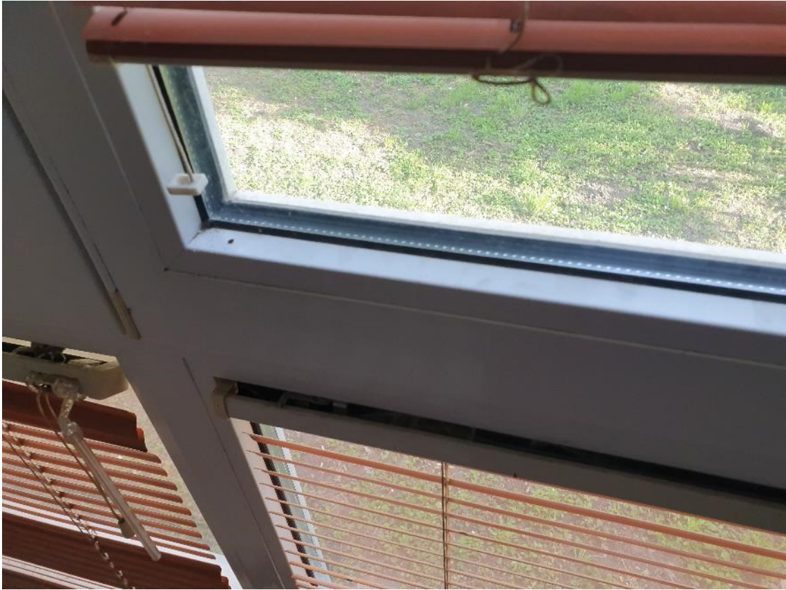
Postojeće stanje- PVC stolarija
