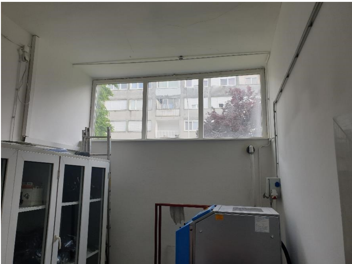
Postojeće stanje- PVC stolarija
