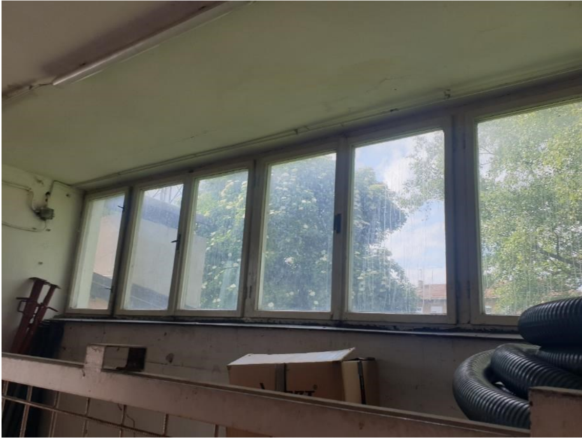
Vanjski drveni prozor na sjevernom pročelju- zid ZG1
