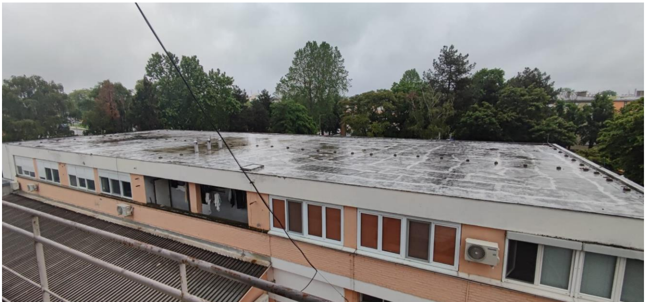
Slika 1: Postojeće stanje krovišta objekta
