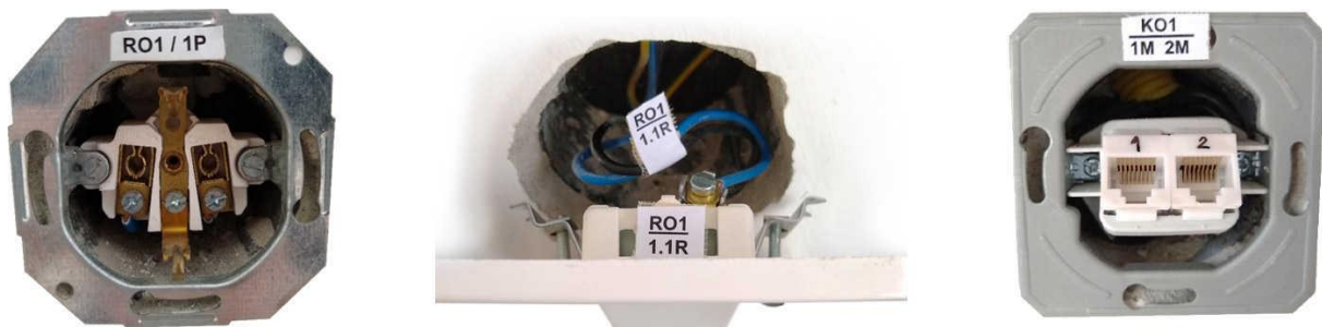
Slika 4.1-4 Označavanje priključnica jake, slabe struje i prekidača
