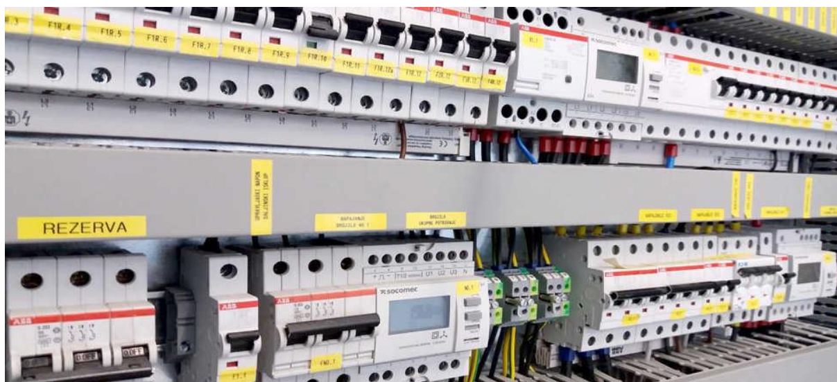
Slika 4.1-5 Označavanje uređaja unutar razvodnih ormara
