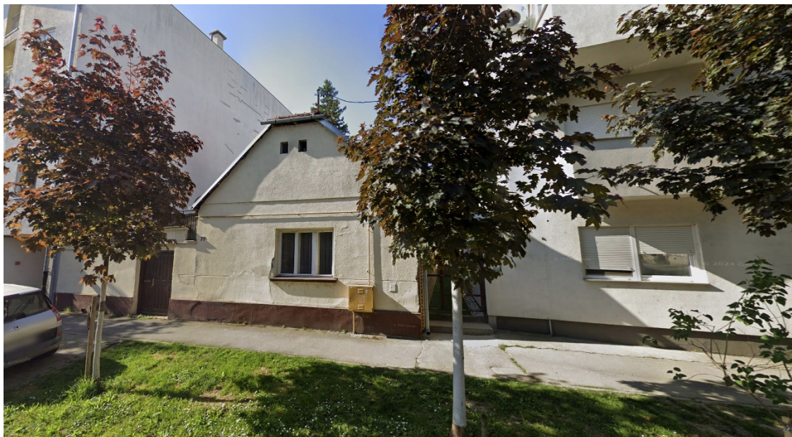
Foto 6A – Postojeće stanje
