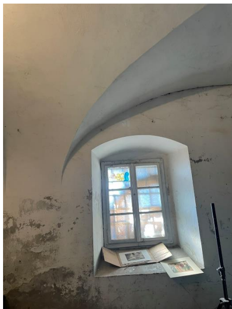
Slika 7 – oštećenja unutarnjeg prostora u prizemlju
