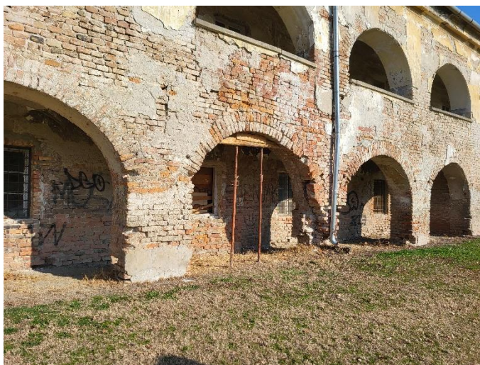
Slika 5 – jedan od poduprtih nosivih lukova na južnom pročelju
