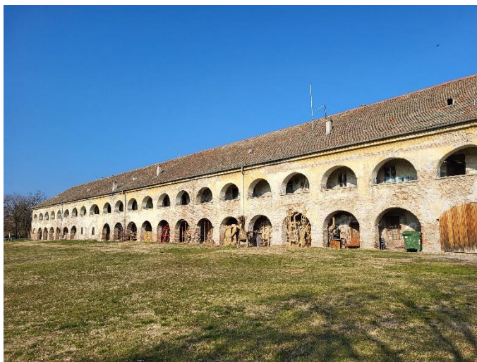
Slika 4 – dio južnog pročelja (pogled sa zelene površine prema Europskoj aveniji)
