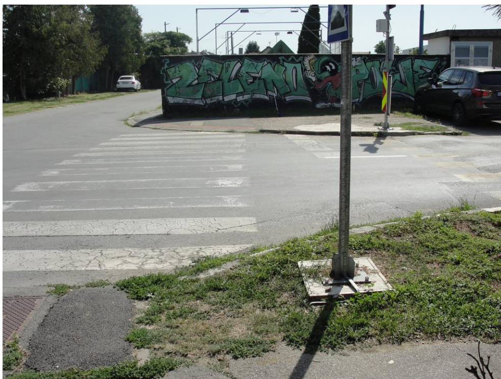
Slika 3. Pješački prijelaz gledan iz smjera zapada
